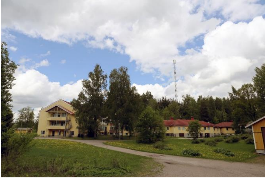
Vanhainkoti ja sen eteläpuolinen piha-alue. Kuva: Ramboll 2022.
