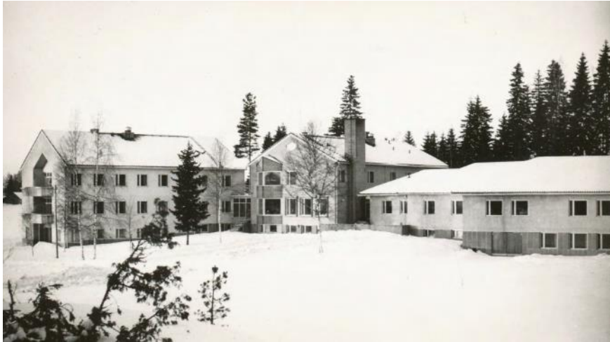
Vanhainkoti vastavalmistuneena vuonna 1954. Kuvasta näkyy alkuperäinen A-talon parvekemuoto, A- ja B-talon välinen terassi sekä C-talon terassi umpikaiteineen. Ulkoportaat C-talon terassin etupuolelle lisättiin todennäköisesti myöhemmässä vaiheessa. Kuva: Pyhäniemen vanhainkodin rakennushistorian selvitys (Sitowise 2021) / Hollolan kunnan kuva-arkisto.
