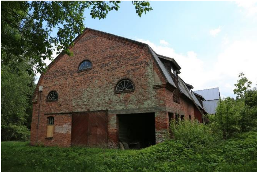
Vanhan puimalarakennuksen pohjoispääty. Kuva: Ramboll 2022.
